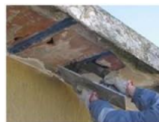
RIPRISTINO BALCONI COMPRESI TRAVI A VISTA
