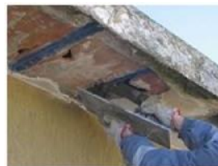
RASATURA MURETTO DI PARAPETTO BALCONI
