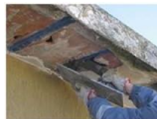
RIPRISTINO BALCONI COMPRESI TRAVI A VISTA
